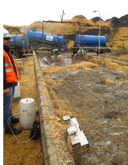
Imagen 4 – Estanque de nitrificación aireado
